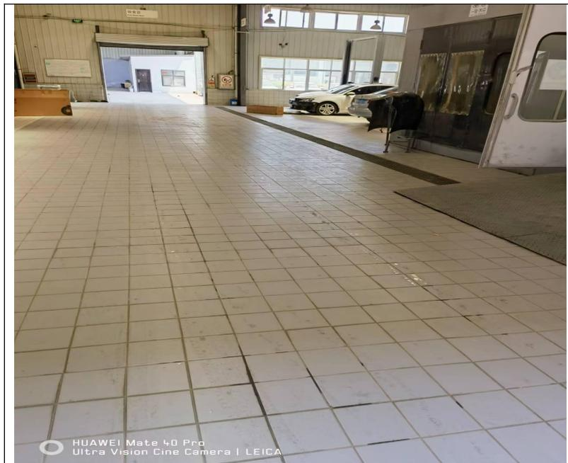
维修车间地面清洗导流槽
