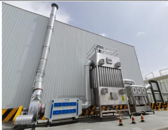
气旋塔+高压电捕焦油器+活性炭吸附废气处理装置
