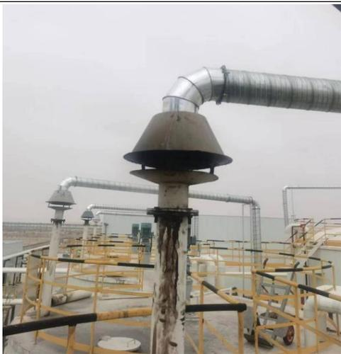
沥青储罐废气收集设施
