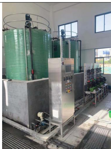
加药设备室内安装
