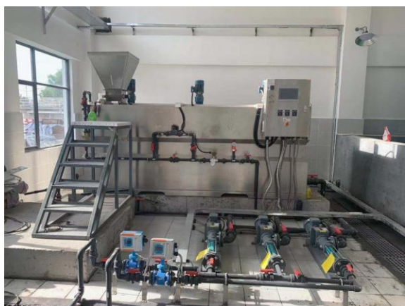
加药设备室内安装
