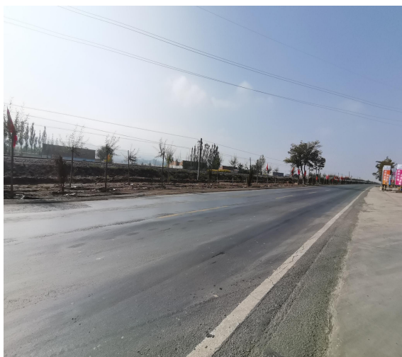
项目南侧为 G109 国道
