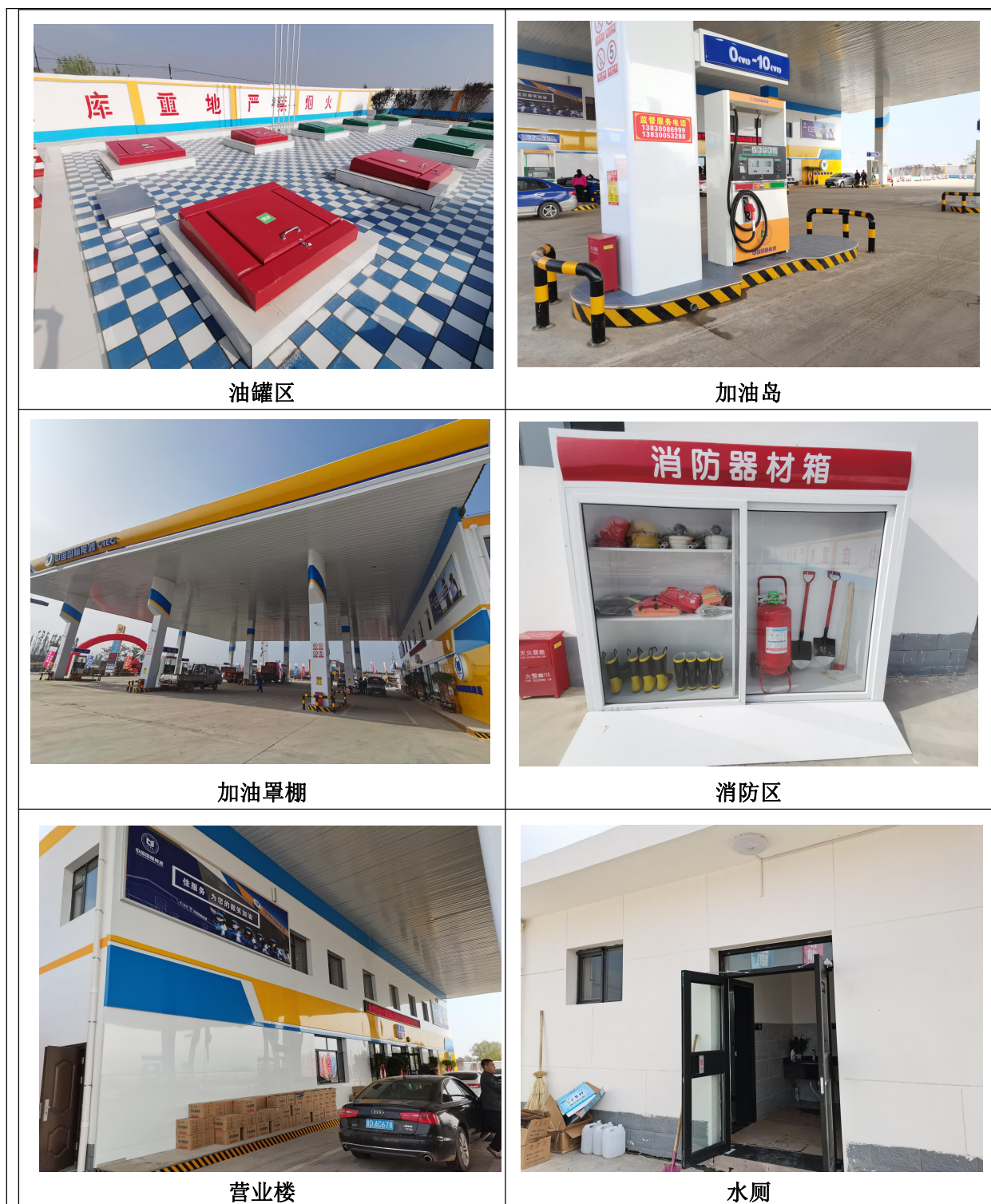
图 4 项目实际建设情况照片
