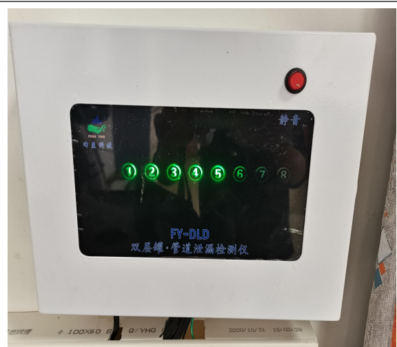
图12 双层罐管道泄漏检测仪
