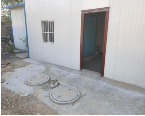
处理设施室内安装
