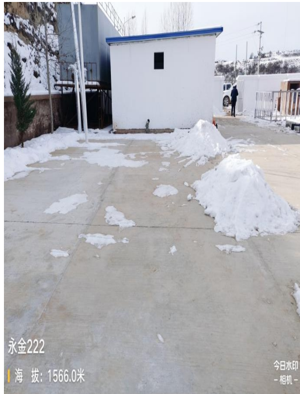
60 清水罐+注水泵房
