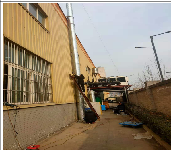
15m 高排气筒
