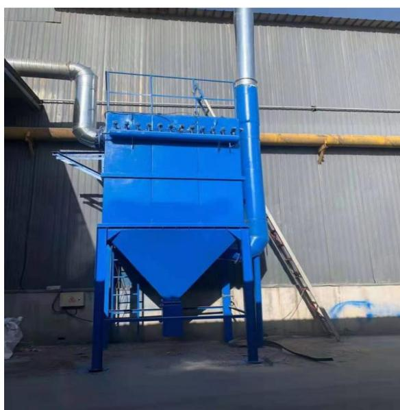
原料配料混合废气和蓄热式马蹄焰熔炉进料口布袋除尘
