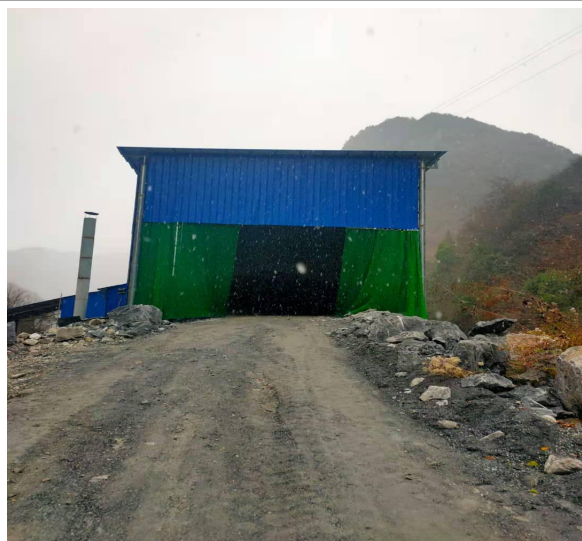
封闭破碎工段
